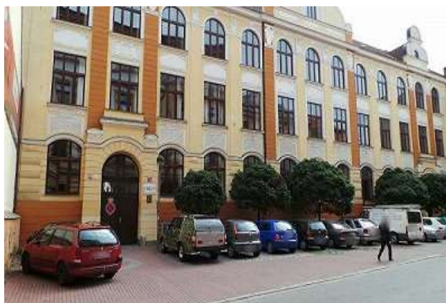
Budova Gymnázia Jírovceva – hlavní vchod z Jírovcevy ulice
